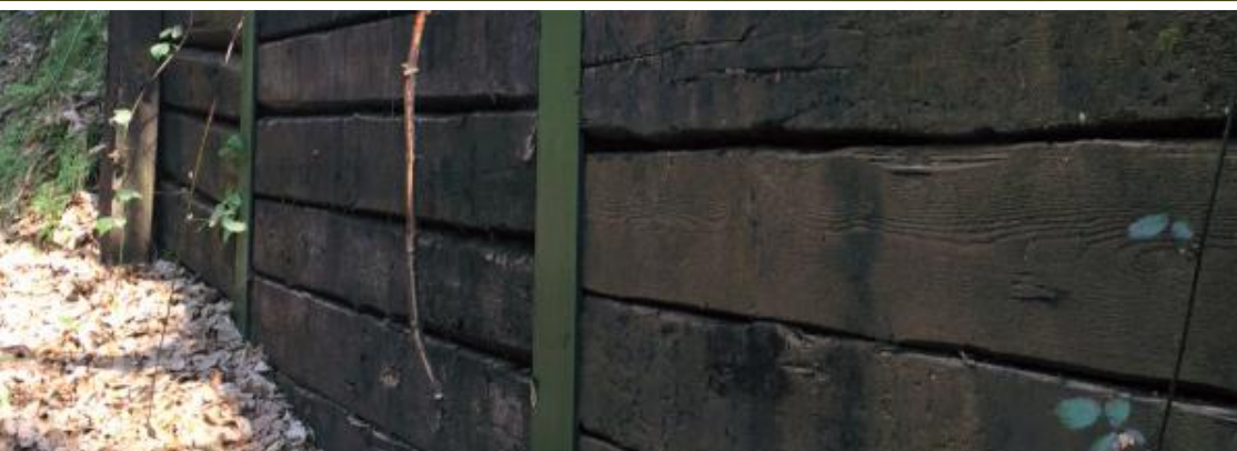
CIERRE DE CONTENCIÓN
