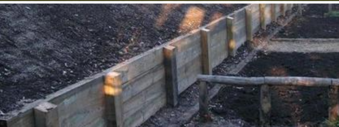
CIERRE DE CONTENCIÓN PILAR MADERA
