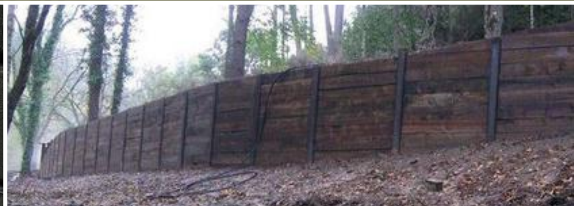
CIERRE DE CONTENCIÓN PILAR HIERRO
